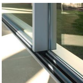
Detalle del nudo central de cruce de dos hojas con marco inferior enrasado con el pavimento exterior e interior. La profundidad del montante de la hoja depende de la presión que deba soportar para que el vidrio no fleche más de lo permitido.
