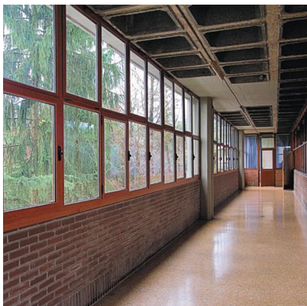
Despacho de Arquitectura: Álvarez y Valle Arquitectos Fotografía: DR Technal
