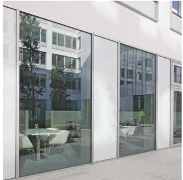
Estudio de arquitectura: Wilmotte & Associés Fotografía: Philippe Ruault
